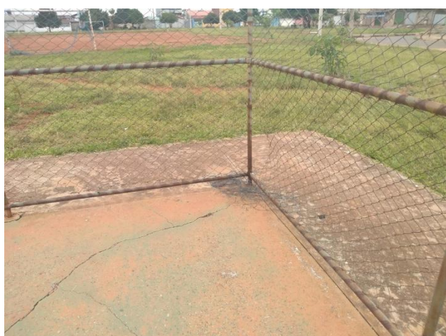
Foto 8: Vista do alambrado – Tela do alambrado danificada.
